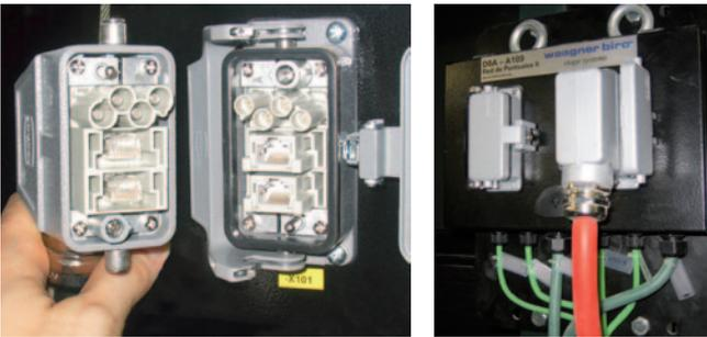
Die Steckstellen bieten jeweils einen oder mehrere Anschlüsse für das Kabel zum mobilen Antrieb.
