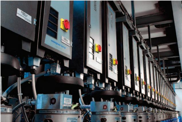
Die Vorteile sind offensichtlich: Die Schaltschränke sind so klein und leicht, dass sie in der direkten Umgebung der zu steuernden Winde montiert werden können. Die Montage ist sehr einfach. Es ist kein gesonderter Schaltschrankraum nötig.
